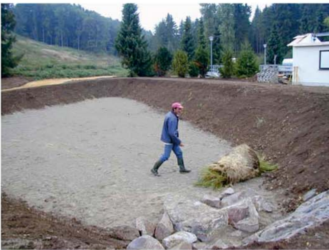
Die Schilfmatte wird aufgerollt angeliefert. The Phragmites-mat is delivered as a roll
