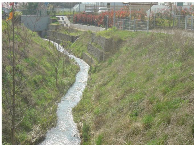
Frühjahr 2007. Außerhalb der Vegetationsperiode ist die Struktur besser zu erkennen. Eine vollständige Begrünung der Bereiche hat stattgefunden. Die massive wasserbauliche Sicherung darunter ist nicht mehr zu erkennen.
