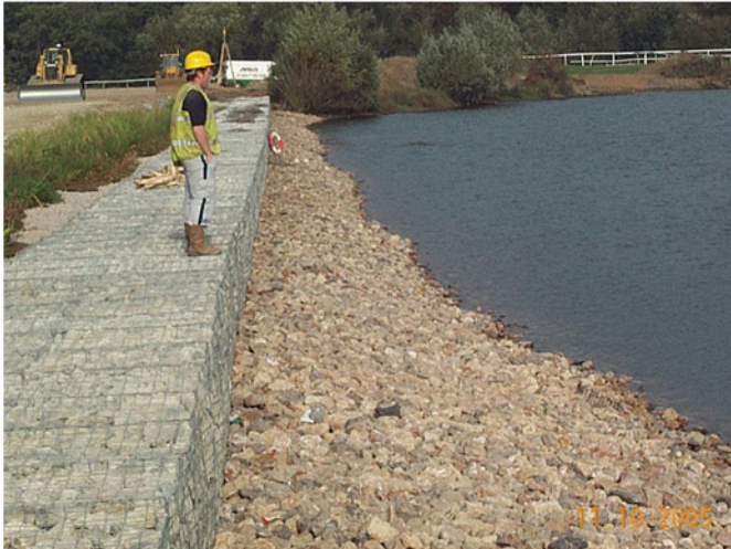
Above: The in-filled lake edge with stone rip rap edge
